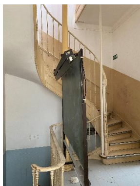
Fig. 8: Núcleo de escadas edifício Escola Primária
