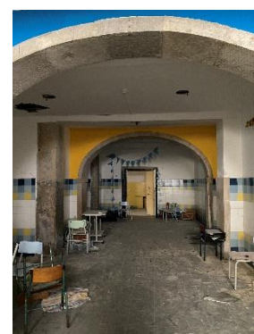
Fig. 7: Refeitório com arcos estruturais
