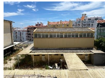
Fig. 10: Exterior edifício Ginásio
